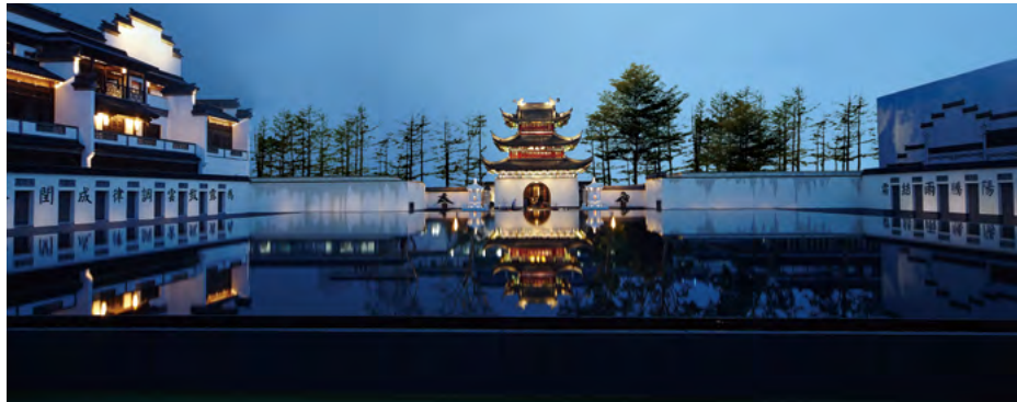
建筑立面与景观照明
